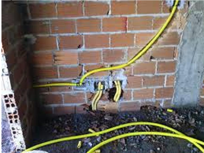
Figura 6- Colocação de conduíte para instalação elétrica em alvenaria convencional
