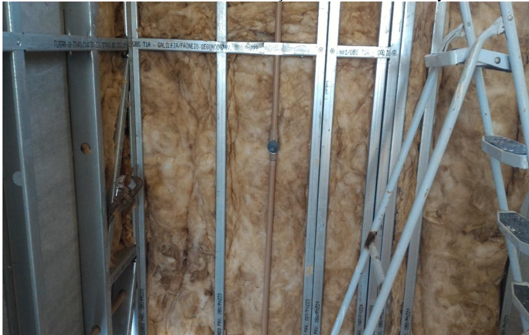
Figura 5- Preenchimento com lã mineral na vedação vertical interna do drywall
