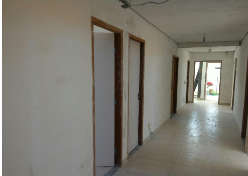
Fotografia 8- Acabamento na vedação em drywall
