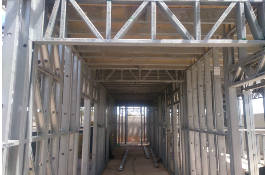
Figura 3- Fase de montagem dos perfis
